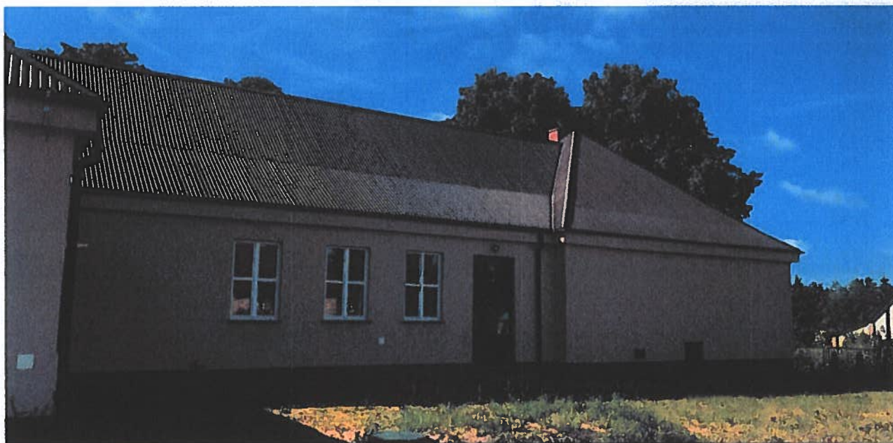
Zdj. 3 Budynek objęty opracowaniem
