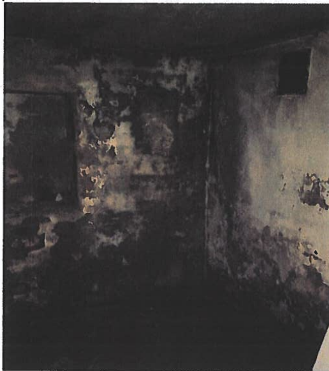
Zdj. 4 Ściany piwnicy, część z posadzką, wejście od wewnątrz budynku.
