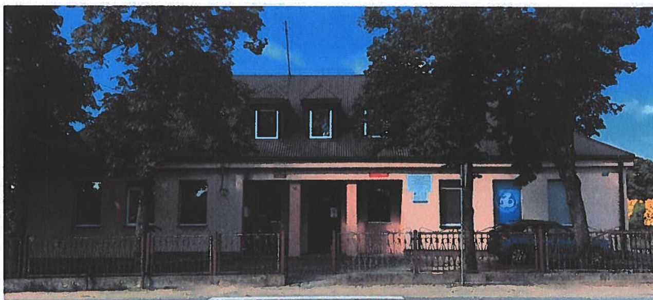
Zdj. 1 Budynek objęty opracowaniem – elewacja frontowa
