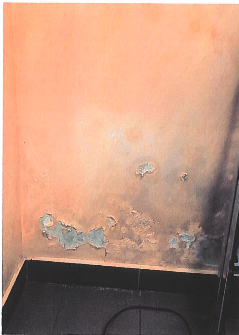
Zdj. 14 Ściany wewnętrzne parteru - podscenie
