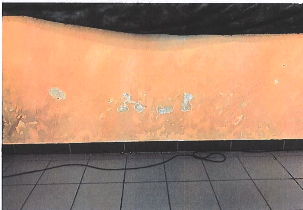
Zdj. 15 Ściany wewnętrzne parteru - podscenie
