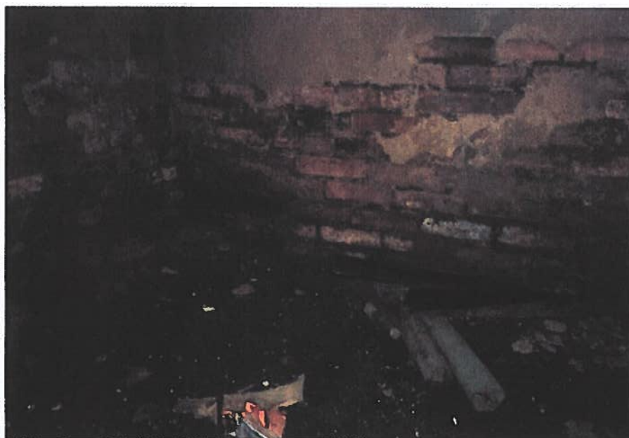
Zdj. 13 Ściany piwnicy z wejściem zewnątrz.
